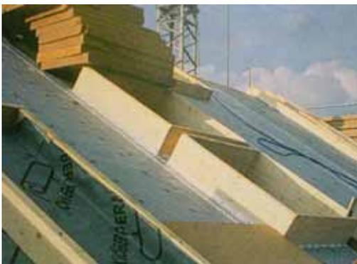
Dann werden die Holzfaserplatten mit einer atmungsaktiven Folie bespannt und die Stöße an den Sparren, werden noch zusätzlich mit einem Dichtungsband abgeklebt und mit kleineren Sparren gekontert.
