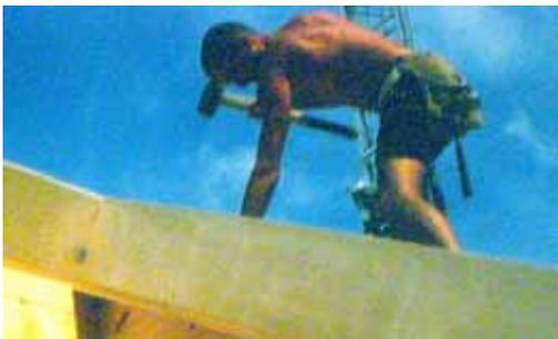
Die Platten müssen präzise und passgenau zwischen die Sparren auf die Deckenschalung eingearbeitet werden.
