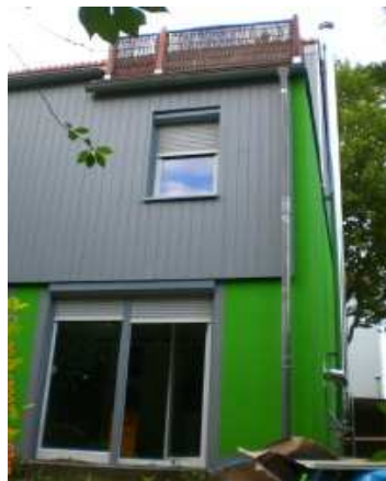
Nachher / Fassadenarbeiten, Neue Außenanlage, Seitlich mit Kamin-Edelstahlrohr.
